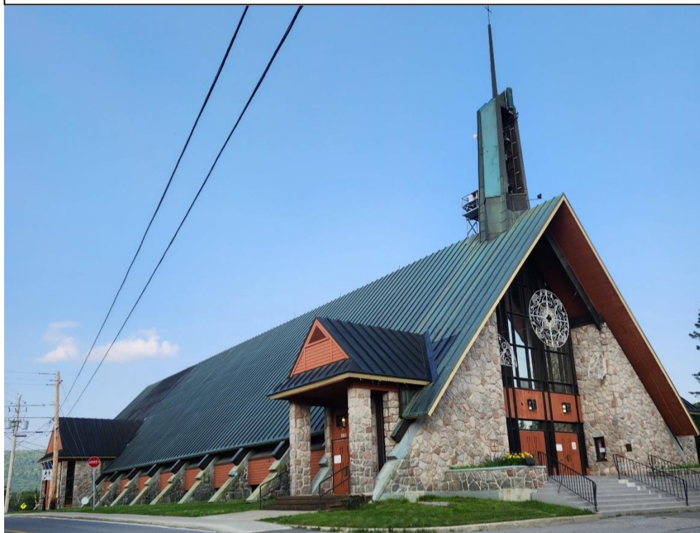
Façade latérale ouest
